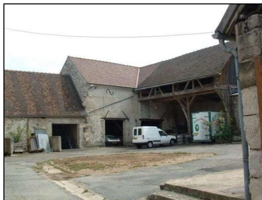
10) Sud-est de la cour
