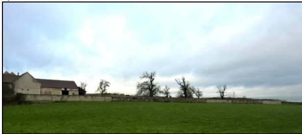
3) Mur de propriété
