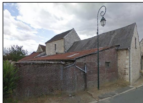
6) L'annexe longeant la rue de Pontoise
