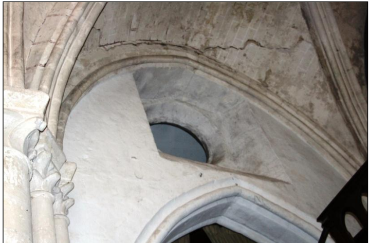
Les roses Sud de la nef donnent dans le collatéral. Le cordon de modillons est absent. Il peut avoir été arasé quand les baies ont été bouchées et le parement chaulé. Ce parement est devenu intérieur avec l'établissement du toit en appentis.
