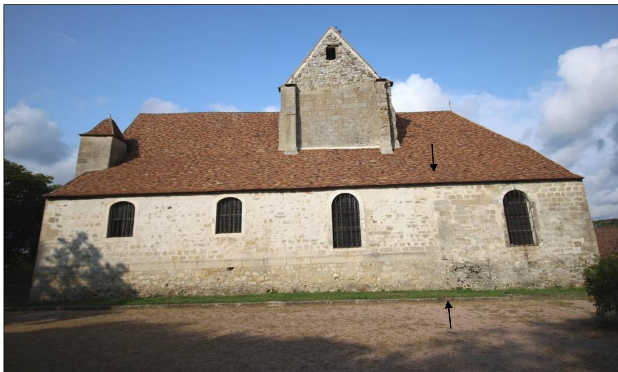
Élévation Sud. Les deux fenêtres de gauche sont semblables aux trois fenêtres Nord de la nef. Les deux fenêtres de droite ont des proportions similaires à la baie bouchée dans le pignon Est.
