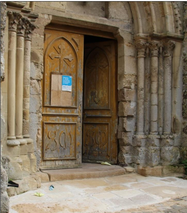
Le portail en 2018. Les blocs formant les colonnettes à gauche et leurs chapiteaux ont été remplacés dans les années 1930.
