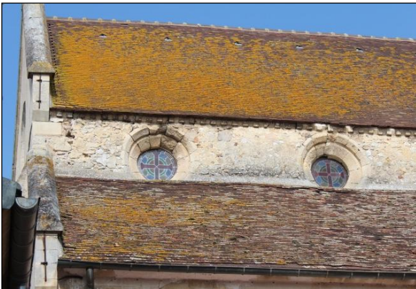
Fenêtres hautes de la nef, côté Sud (photo de gauche) et Nord (photo de droite). Au-dessus des baies : corniches à modillons, aussi semblables à celle de Vallangoujard. Au-dessous : larmier en pierre protégeant le faîte du versant du collatéral.
