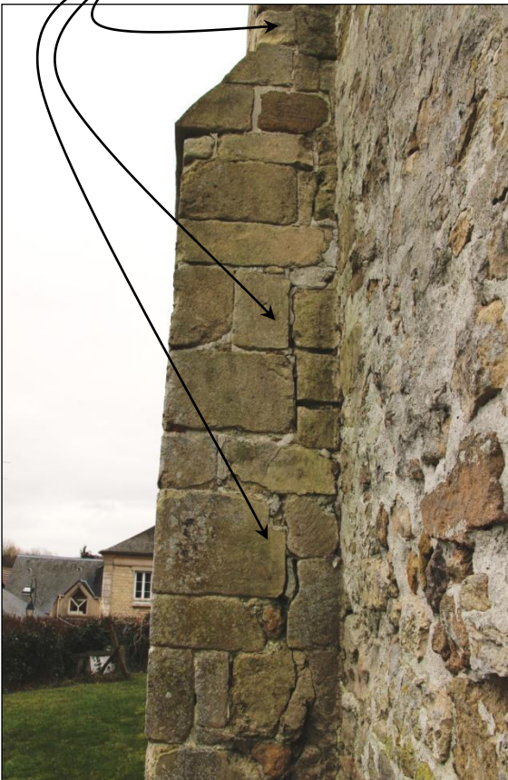
Sur les contreforts de la travée 1, les joints superposés suggèrent que le devant des contreforts a été rapporté. Dans le mur de bouchage de la travée 2 apparaît une petite porte bouchée en maçonnerie, probablement contemporaine de la construction du bouchage, tandis que les fenêtres en anse de panier semblent avoir été ouvertes ou agrandies plus tardivement.
