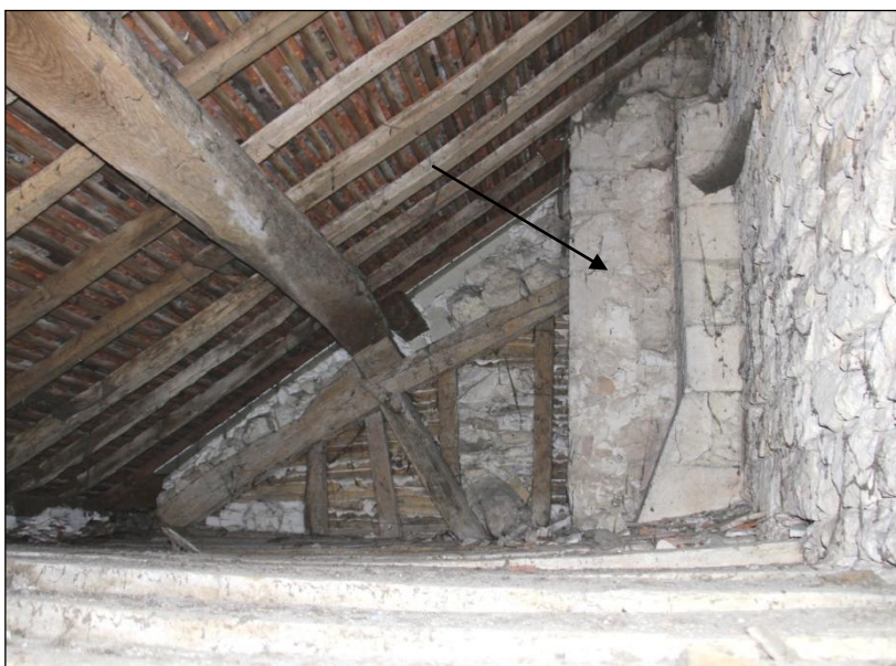
Dans le comble de la sacristie, deux contreforts au droit du double arc triomphal.
