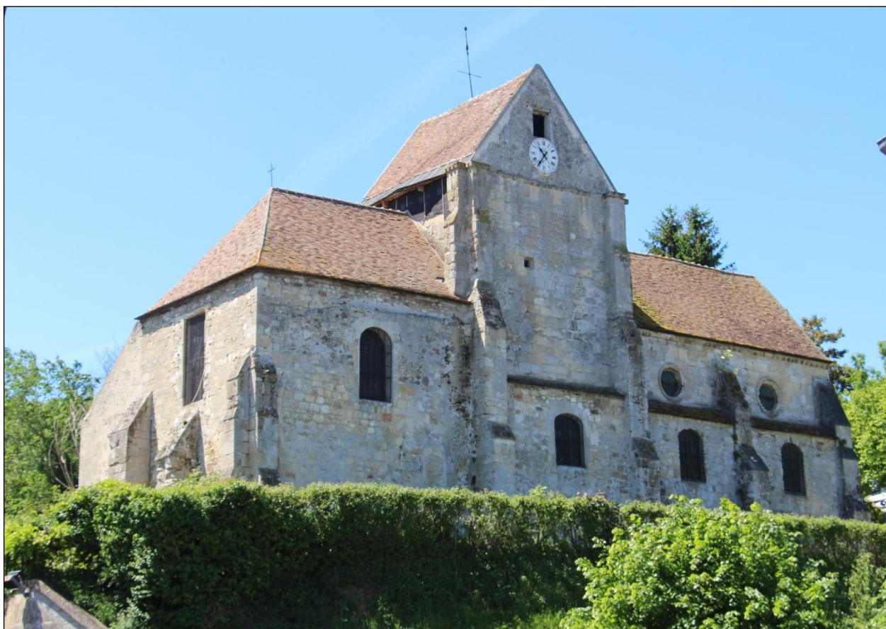
Vue générale Nord-Est, photo CG 2020.
