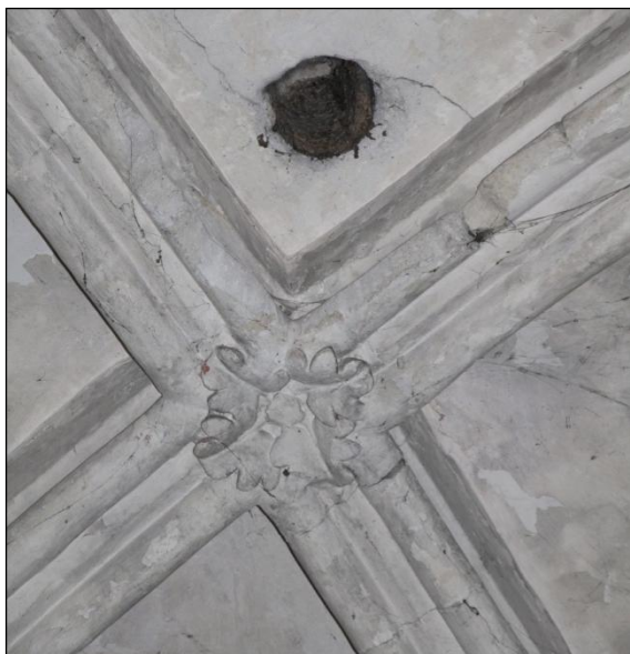
Détail du profil de mouluration des arcs et de la clef de voûte sculptée. Travée 1.
