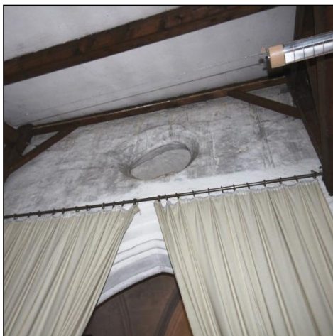
Les roses Sud de la nef donnent dans le collatéral. Le cordon de modillons est absent. Il peut avoir été arasé quand les baies ont été bouchées et le parement chaulé. Ce parement est devenu intérieur avec l'établissement du toit en appentis.
