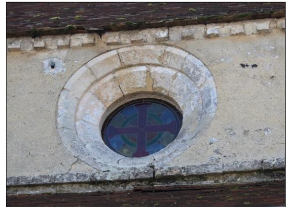
Fenêtres hautes de la nef, côté Sud (photo de gauche) et Nord (photo de droite). Au-dessus des baies : corniches à modillons, aussi semblables à celle de Vallangoujard. Au-dessous : larmier en pierre protégeant le faîte du versant du collatéral.
