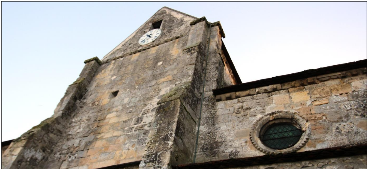
Continuité de l'appareil en pierre de taille de la nef haute, du clocher et de ses contreforts.
