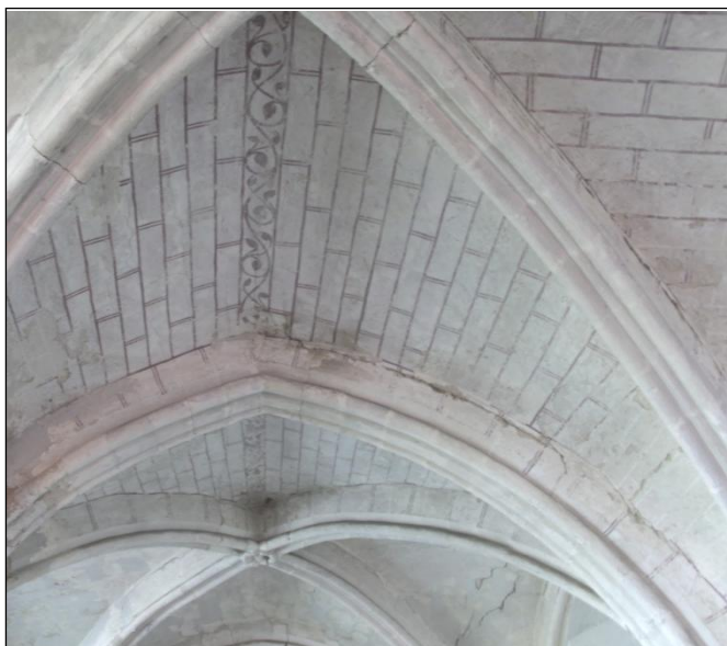
Décor peint : faux joints à double trait peint en rouge sur badigeon blanc, frise de rinceaux au sommet du voûtain. Travée occidentale.
