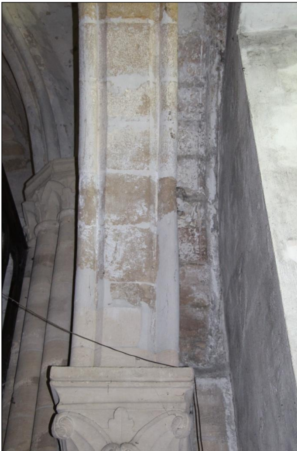
Au revers des grandes arcades Nord de la nef : une voussure en pierre de taille, et sur celle de la travée 1, un décor de faux joints analogue à celui des voûtes. Le collatéral ou un croisillon de transept a pu exister.
