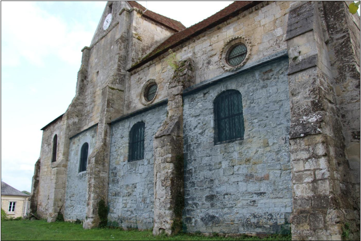
En partie haute les fenêtres hautes ouvertes dans le mur en pierre de taille sont XIIe ou XIIIe. En partie basse les murs entre les contreforts (en bleu) ont été rapportés tardivement. Les parements comportent des blocs de réemploi. Les fenêtres basses en anse de panier pourraient dater du XVIIe ou XVIIIe.
