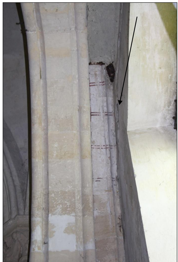
Au revers des grandes arcades Nord de la nef : une voussure en pierre de taille, et sur celle de la travée 1, un décor de faux joints analogue à celui des voûtes. Le collatéral ou un croisillon de transept a pu exister.
