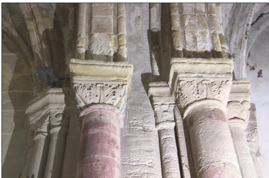
Chapiteaux de la pile Nord.
