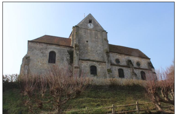
Élévation Nord de l'église. Photo CG 2014.
