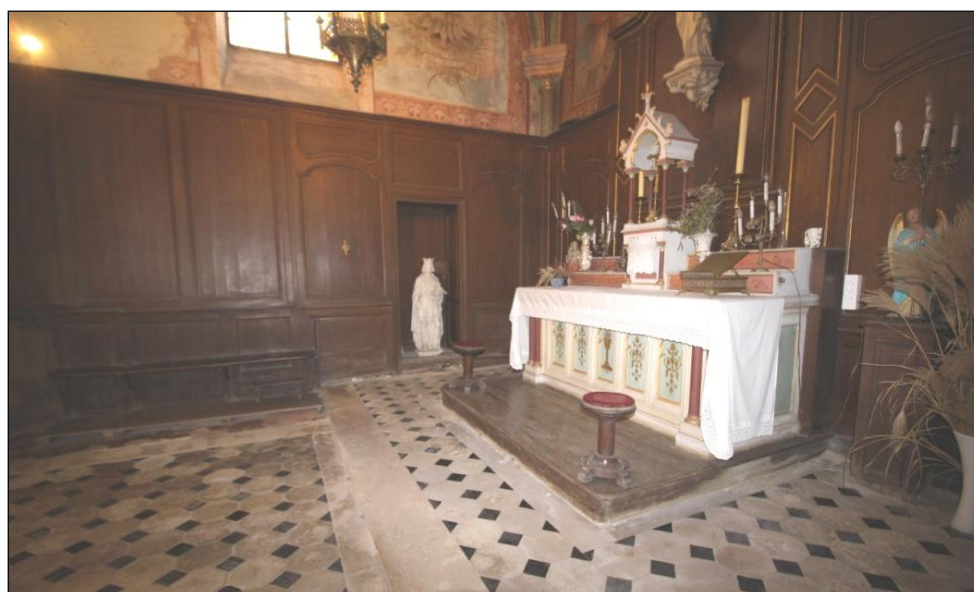
Vue du sanctuaire avec le maître-autel. Dans le lambris mural Nord, des panneaux de réemploi d'un lambris plus ancien. Au sol, un dallage XIXe avec une partie en tommettes, conservée sous une estrade de bancs de chœur côté Nord.
