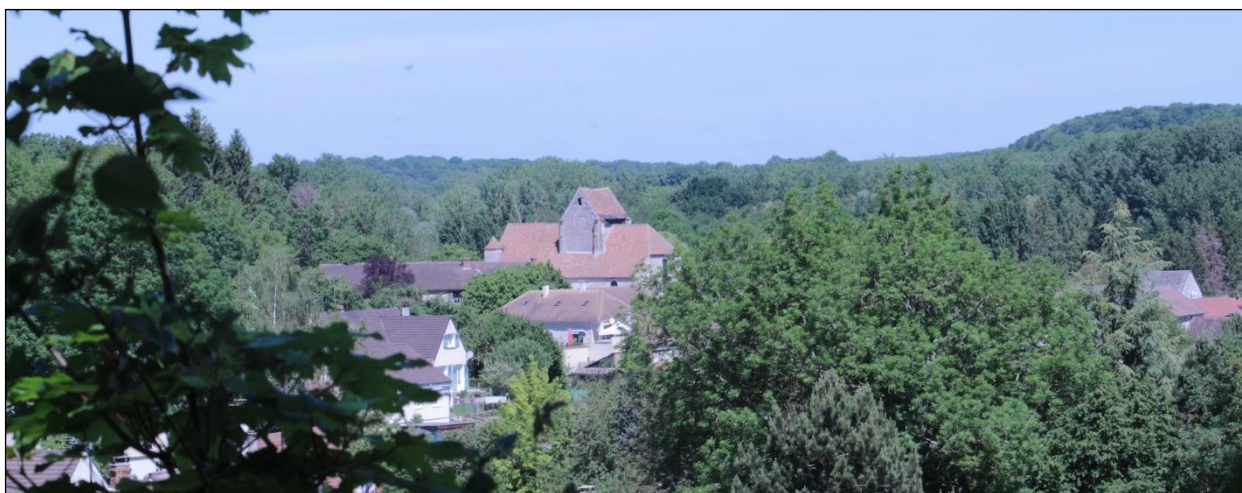
Vue lointaine côté Sud, depuis le Calvaire. Photo CG 2020.
