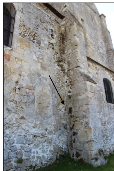
Côté Nord : un seul contrefort.
