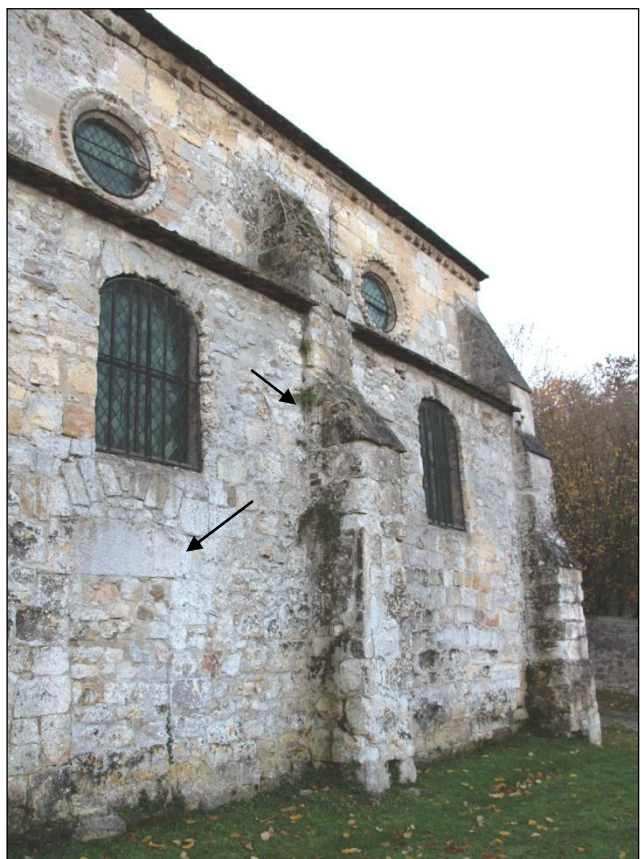
Sur les contreforts de la travée 1, les joints superposés suggèrent que le devant des contreforts a été rapporté. Dans le mur de bouchage de la travée 2 apparaît une petite porte bouchée en maçonnerie, probablement contemporaine de la construction du bouchage, tandis que les fenêtres en anse de panier semblent avoir été ouvertes ou agrandies plus tardivement.
