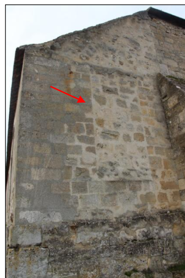
En partie Est, un mur en gros moellons taillés. La même maçonnerie se retrouve sur le pignon en retour et sur le contrefort attenant. La jonction avec la façade Sud du collatéral n'est pas au droit de la cloison que le sépare de la sacristie.
