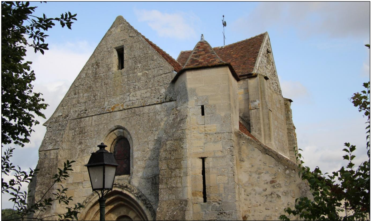
Détail des parties hautes de la façade. Les rampants du pignon de la nef sont en mortier, autrefois il existait probablement un rondelis en pierre de taille. La tourelle d'escalier a été reconstruite en partie haute et couverte d'un petit toit pyramidal, vers 1990 (à Livilliers aussi, une poivrière a été reconstruite : en pierre, vers 1935).
