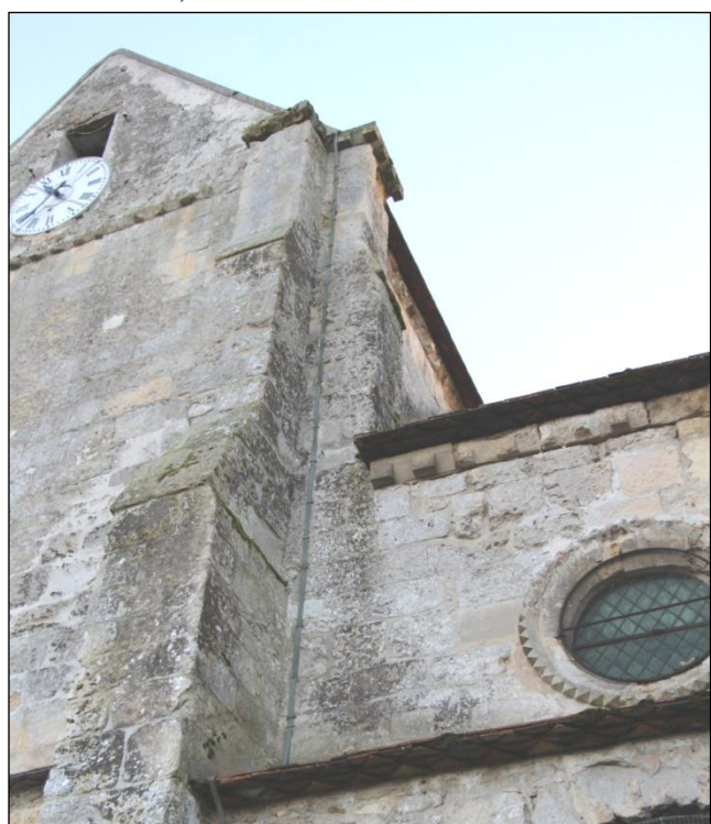
Détail des roses, avec un décor différent au pourtour. Continuité de l'appareil en pierre de taille sur nef et clocher.
