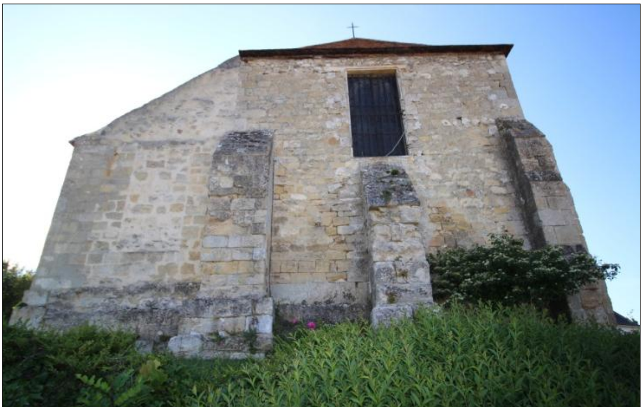
Elévation Est. Photo CG 2020. Parements en gros moellons taillés en partie basse, et de plus petits moellons en partie haute. Deux baies carrées de mêmes proportions, celle du collatéral étant bouchée en maçonnerie. Trois contreforts différents. Celui de gauche, à cheval entre le chœur et le collatéral, ne peut être que contemporain ou postérieur à la construction du collatéral.
