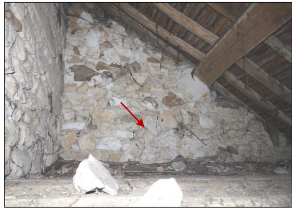
Arc en moellons dans le parement extérieur et dans le parement intérieur.
