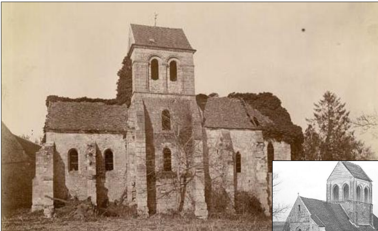
L'église de Mézières, vue du Sud. Félix Martin-Sabon, avant 1896 (base Mémoire). Les baies du clocher ont été réduites, partiellement bouchées en maçonnerie.
