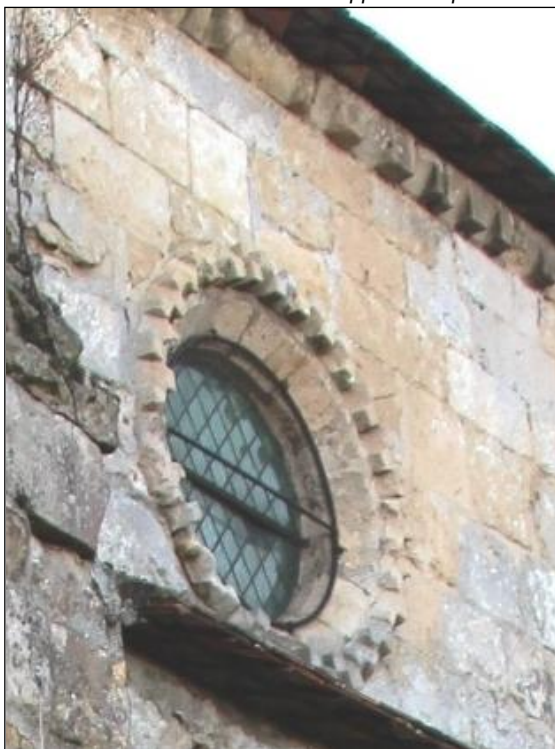
Détail des roses, avec un décor différent au pourtour. Continuité de l'appareil en pierre de taille sur nef et clocher.
