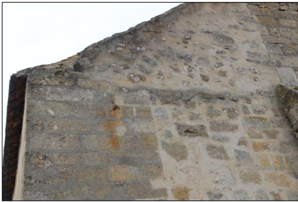
Arc en moellons dans le parement extérieur et dans le parement intérieur.
