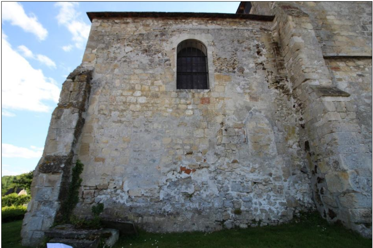
Mur Nord du chœur. Photo CG 2020. A droite de la façade, deux chaînes en pierre de taille. Traces de deux portes bouchées.
